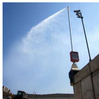
Figura 7: Esempio di sistema di irrigazione a pioggia per abbattimento polveri
